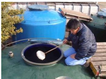
手作業で仕上げています
